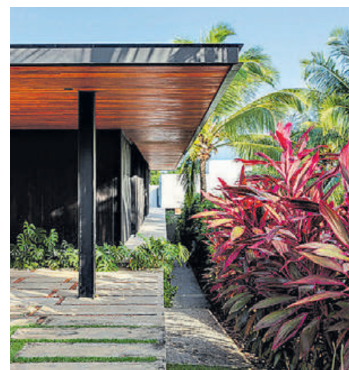
A estrutura de vigas de aço permite que a cobertura avance 1,80m em balanço para criar generosos beirais
